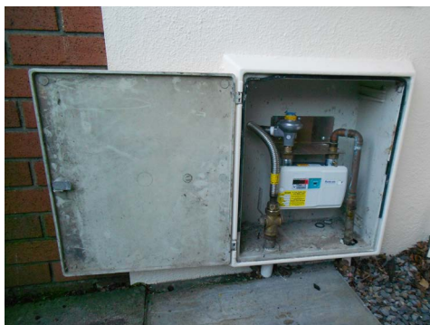
Le compteur et la zone l'entourant avant le renouvellement des services.
