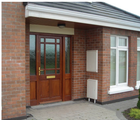
Przykładowa lokalizacja skrzynki licznika w miejscu, gdzie może zostać zamknięta.
