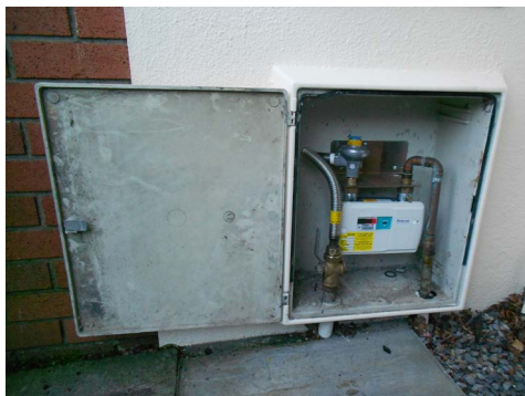
Skrzynka licznika i jej okolice przed modernizacją instalacji.
